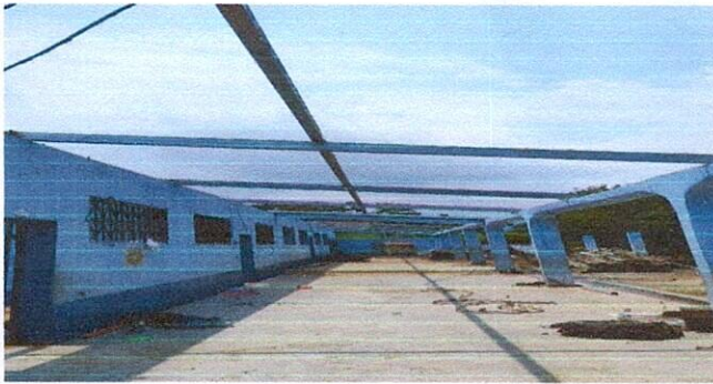
Foto1: Aulas en Proceso de colocación de tubos metalicos.
