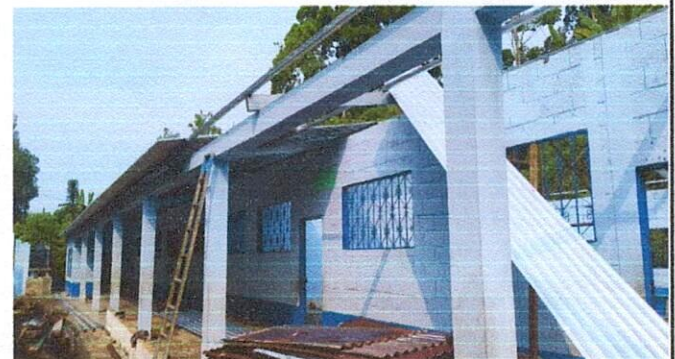
Foto 4: Dirección y aula en colocación de láminas.
