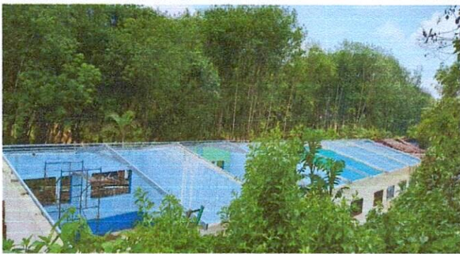
Foto 3: Tubos colocados en el techo completo de la Escuela.
