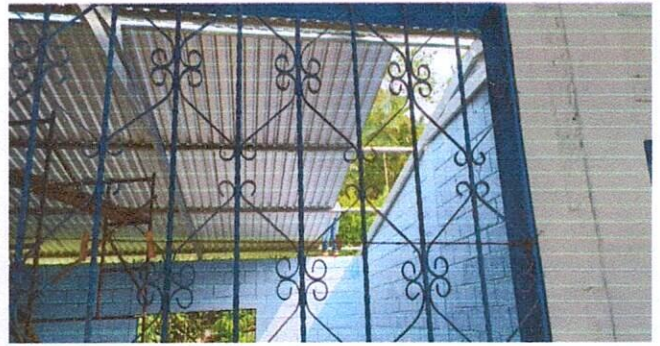
Foto 6: Aulas en proceso de finalización del techado.
