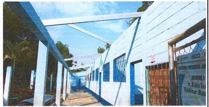
Foto 2: Colocación de tubos en el corredor.
