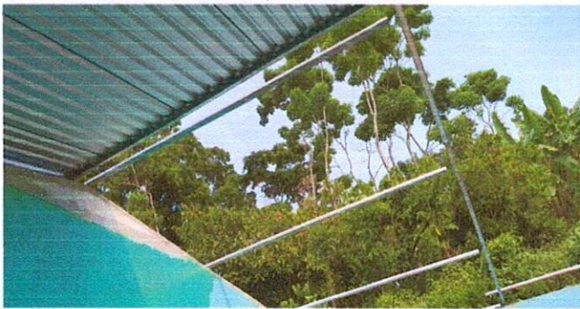
Foto 5: Aulas en proceso de colocación de laminas.
